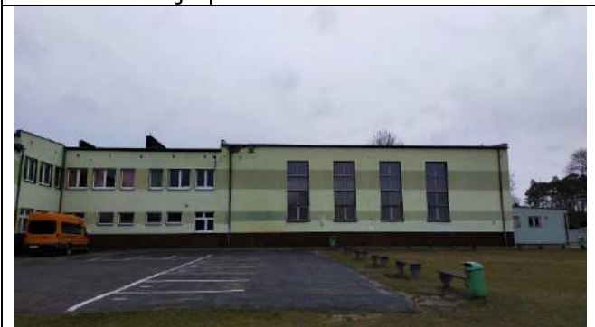
Fot. 9 Elewacja południowa
