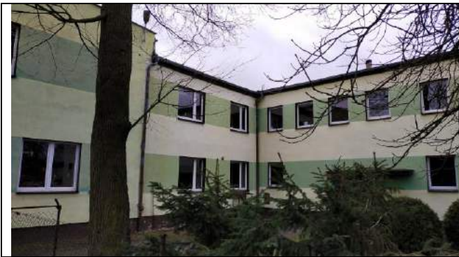
Fot. 5 Elewacja zachodnia / północna
