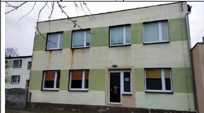
Fot. 7 Elewacja południowa
