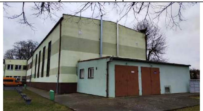
Fot. 10 Elewacja południowa / wschodnia
