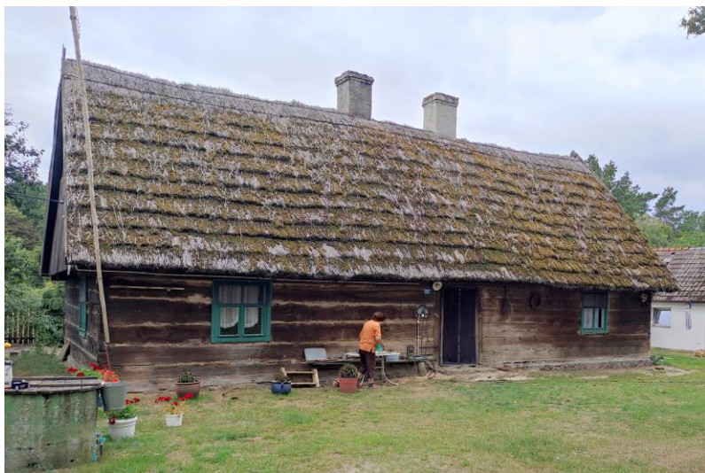
Zdjęcie nr 8. Bolewico nr 18, dom mieszkalny
